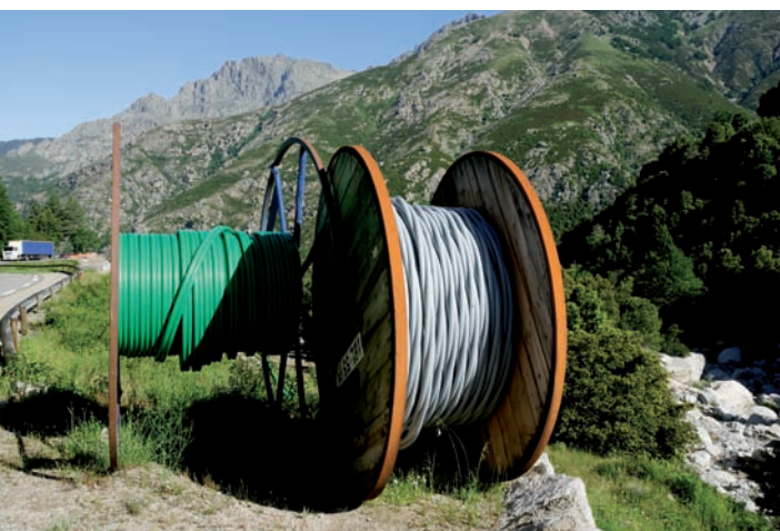
Fourreau HD (haut débit) en cours d'installation en Corse-du-Sud.
