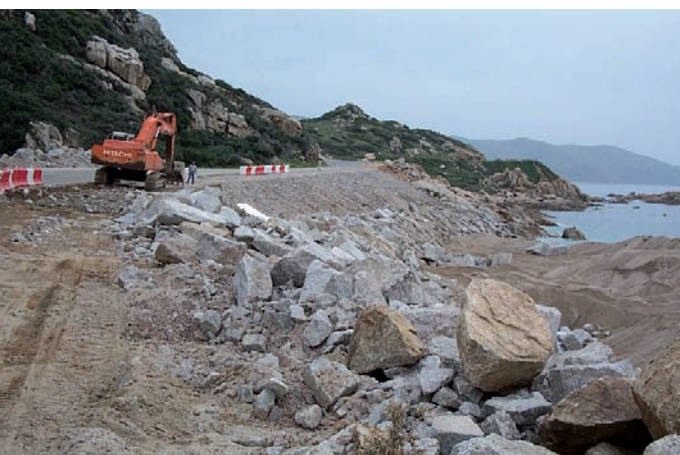
Enrochement de protection et élargissement de la route littorale : la route départementale RD 81.
