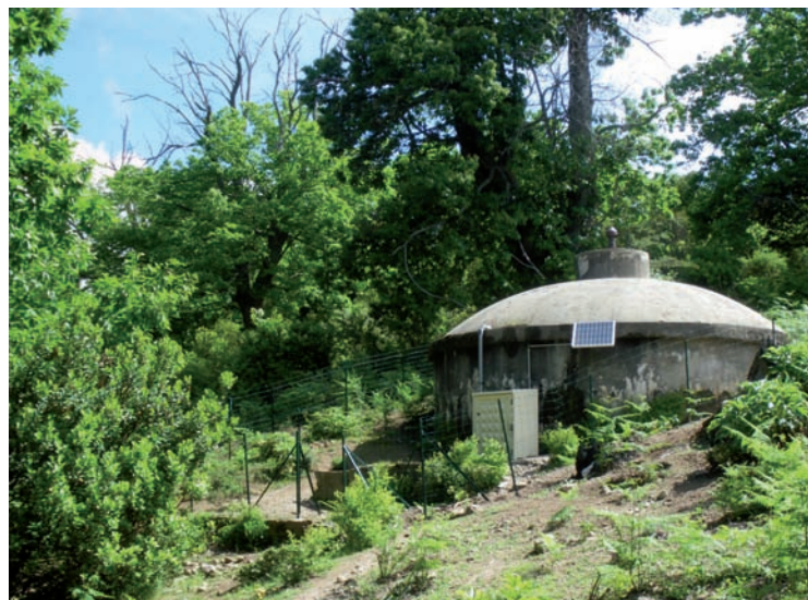
Forage alimenté par énergie solaire et réservoir d'eau potable dans une commune rurale.
